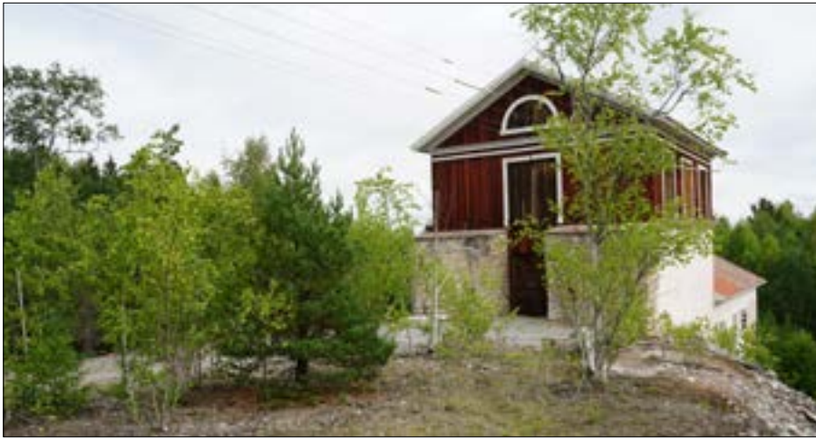
Nästa område som kommer att åtgärdas är hjulhuset och krossplan. Foto: Ulrika Larson
