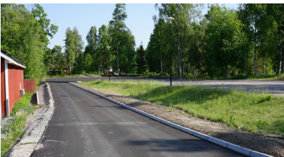
Nedre parkeringen, bussparkeringen och parkeringen vid Gruvkontoret är färdigställda.
