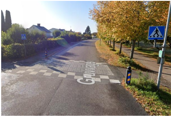
Figur 44 Hastighetssäkrad passage Gruvvägen, Sala
