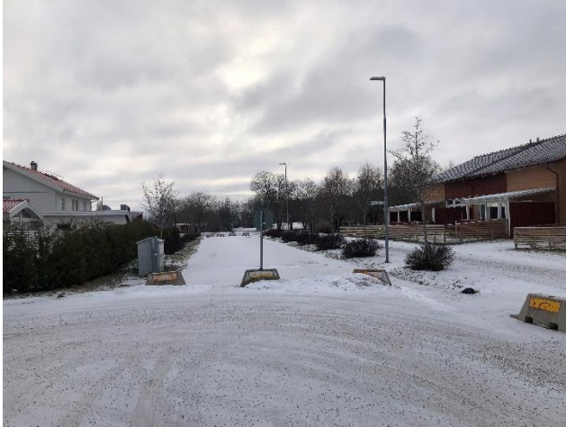
Figur 25 Betongsuggor på Galaxgatan sett åt söder.
