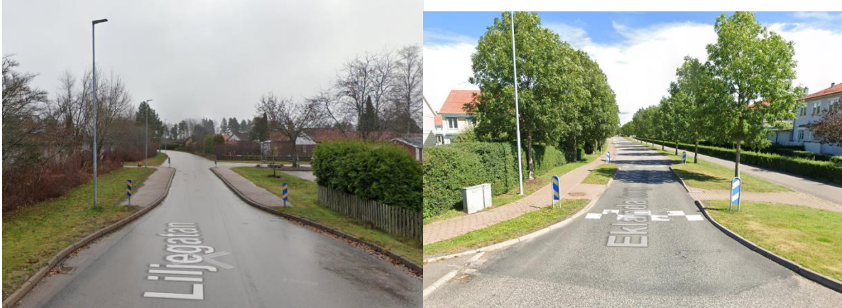
Figur 54 Exempel på avsmalningar som minskar hastigheter och prioriterar fordonstrafik i ena riktningen. Liljegatan, Västerås, och Eklanda Torg, Mölndal
