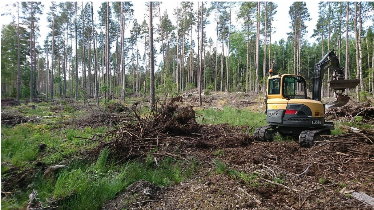
Bild 1; Grävare som har använts vid provgropsgrävningen.
