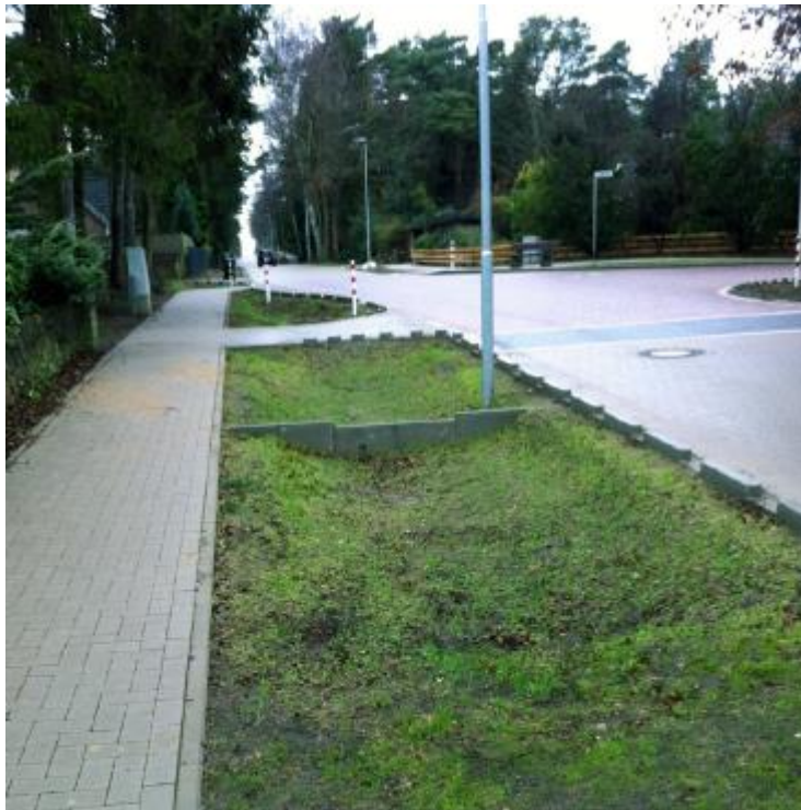
Figur 23. Exempel på svackdike med dämme i gatumiljö. Foto WRS, källa Stockholm Vatten och Avfall.
